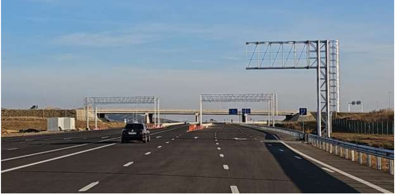
Ahmetbeyli – Fuzuli – Şuşa Otoyolu Projesi
