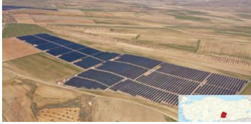
Elbistan GES (Kahramanmaraş)
