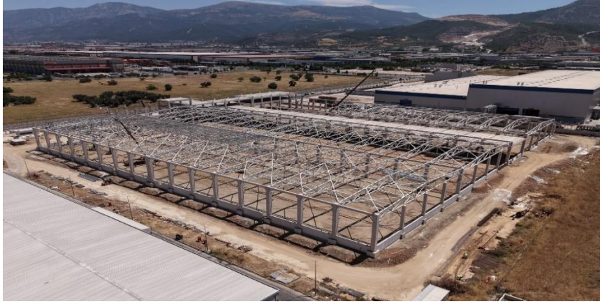
İnşaata Devam Eden Manisa Ambalaj Tesisi 2 Binası
